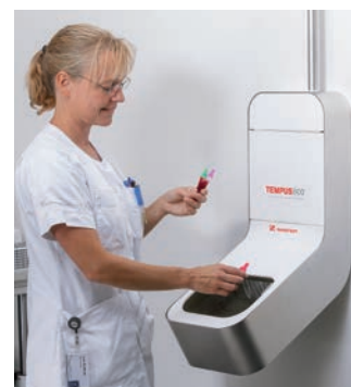
I campioni vengono ricevuti nel modulo di connessione Tempus600® o nel vassoio di ricezione in laboratorio.
