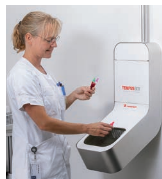
Пробы поступают в модуль подключения Tempus600® к автоматизированным решениям многих производителей или в ручное приемное устройство в лаборатории для доступа (оператором, лаборантом).
