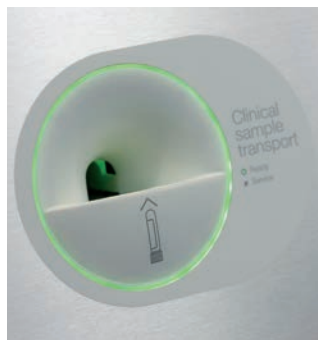
Skúmavky so vzorkami sa vložia do vkladacieho otvoru stanice Vita.
