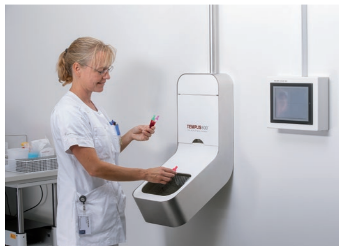
Die Proben kommen in der Empfangsvorrichtung an und können dort problemlos vom Personal entnommen werden.
