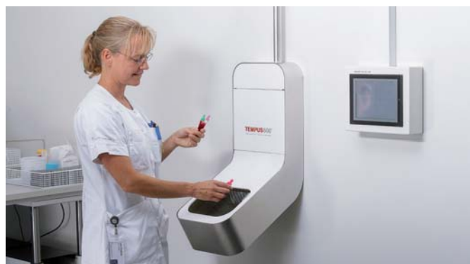
Vzorky vstupují do přijímací stanice, odkud jsou odebírány.
