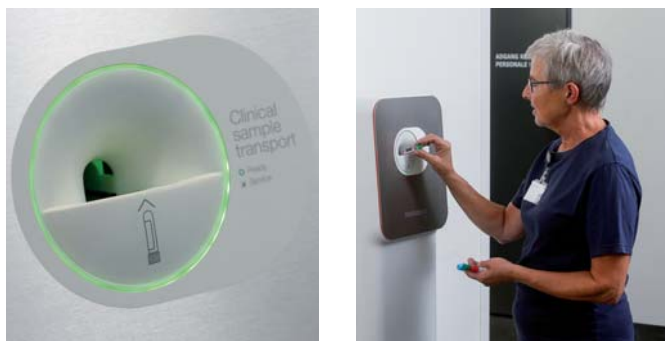
Zkumavky na vzorky se vkládají do sběrných bodů ve stanici Vita.
